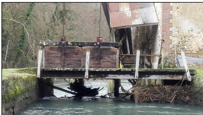
Embâcles obstruant les vannages du moulin
